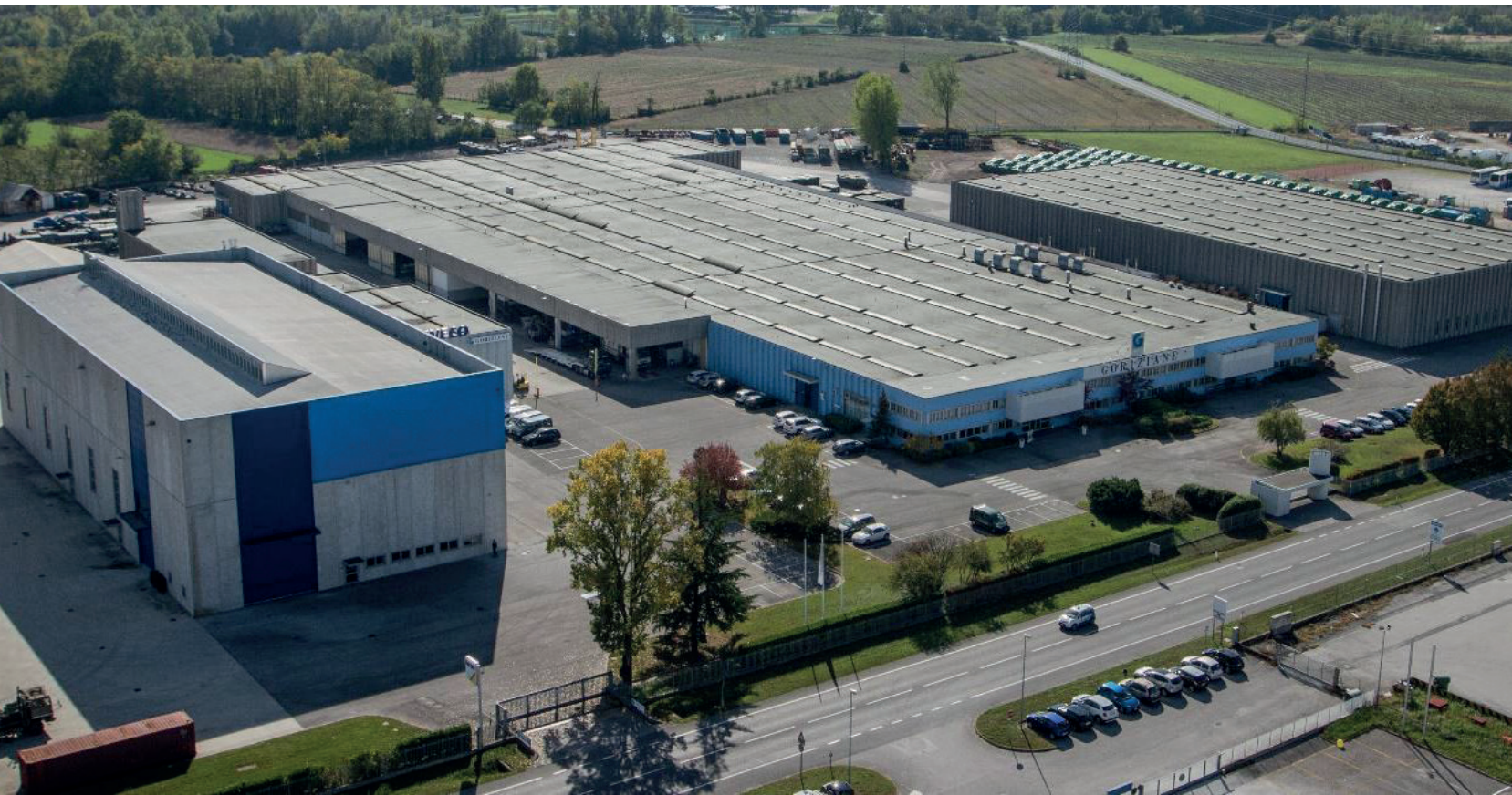
LO STABILIMENTO SI TROVA NELL'AREA INDUSTRIALE DI VILLESSE, PER UN TOTALE DI 150MILA METRI QUADRATI
